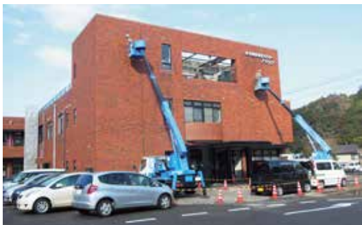
鳥取県中部地震からの復旧工事着々と!
