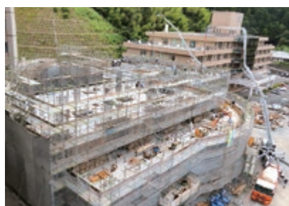
中央棟（3階躯体コンクリート打設）
