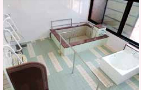
デイサービス浴室改修後
