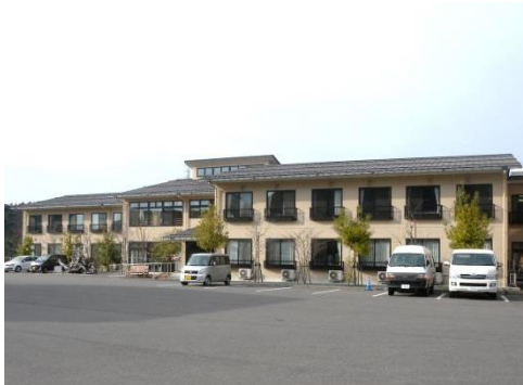
ユニット棟西
