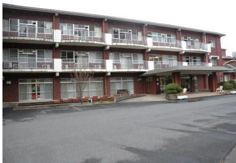
ユニット棟東・認知症専門棟
