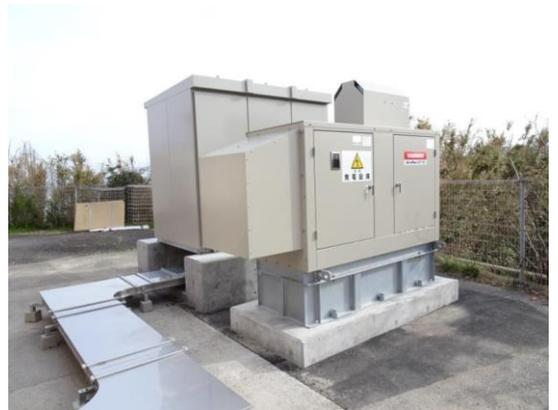
停電に備え、鳥取県の施設整備交付金を活用して非常用自家発電機を設置しました。この発電機の設置により停電時に最低でも7時間以上施設に電力を供給することが可能となりました。
