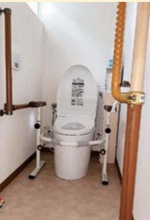
【生活環境調整】 トイレに手すりを設置することで安全性と快適性がアップ
